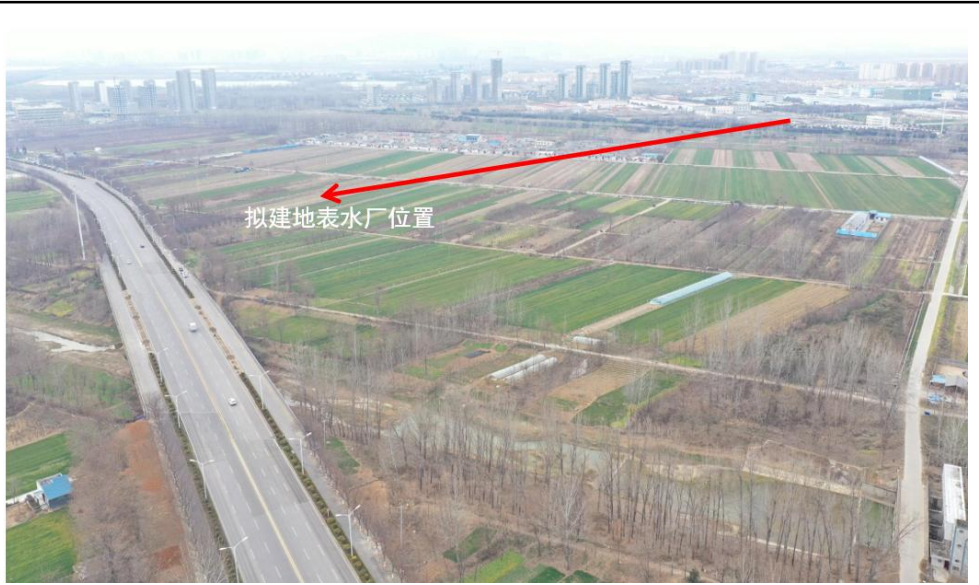
图 1-8 地表水厂厂址现状图
