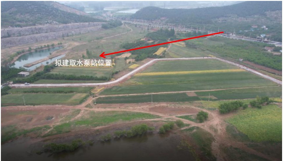
图 1-9 取水泵站厂址现状图
